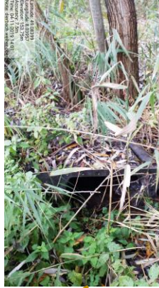
Zugewachsener „Zulauf-Graben“ mit Plastikverschalung
